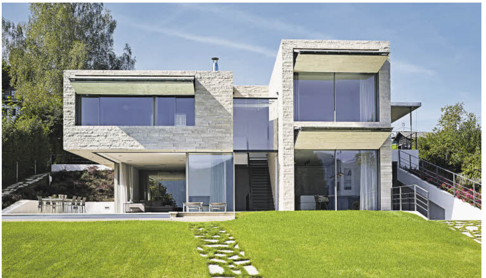
Offene Fenster: Die Fassadenteile aus Kalkstein lassen sich hochfahren.
